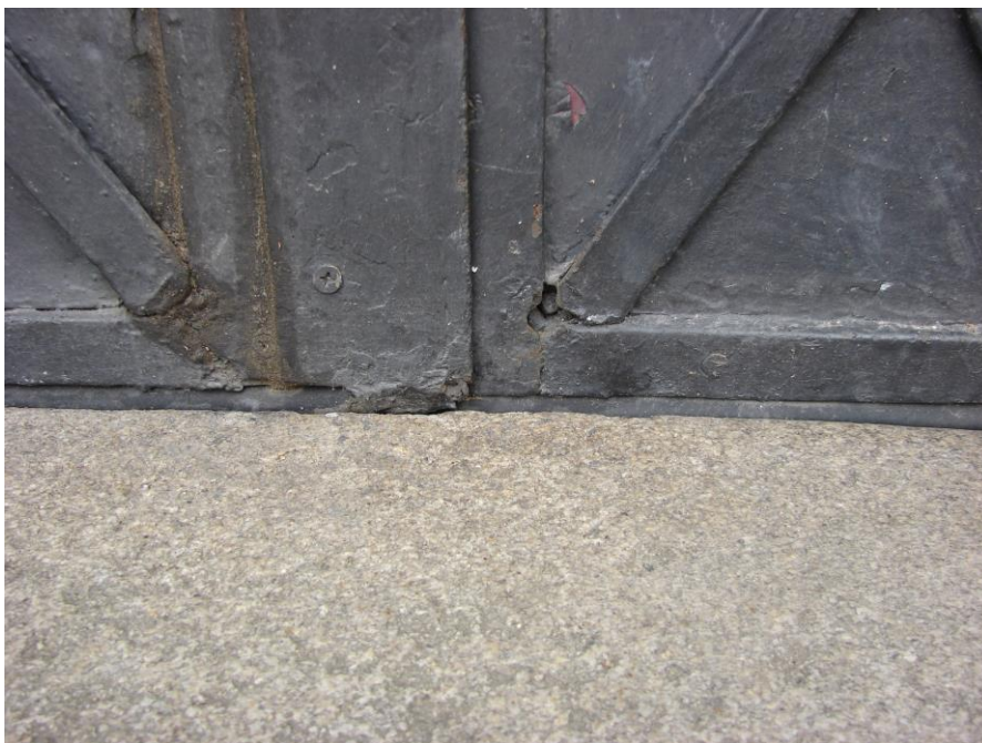
Koroze spodních částí vrat
