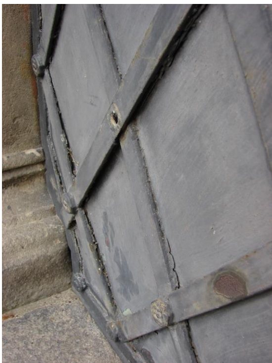
Vydutí a koroze pásovin z vnitřní strany
